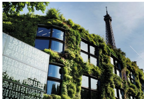
Le mur végétal © musée du quai Branly – Jacques Chirac, photo Cyril Zannettacci
